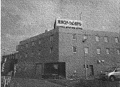
▲共和ステーションホテル
